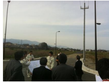
建設が進められている都市計画道路
