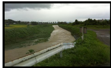
9月4日10時藤井議員撮影 真野川、荒木橋周辺
